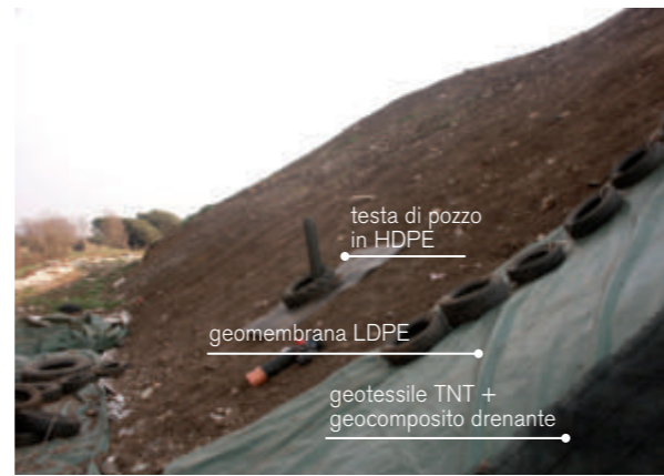
figura 2: Esempio di capping definitivo di discarica.
