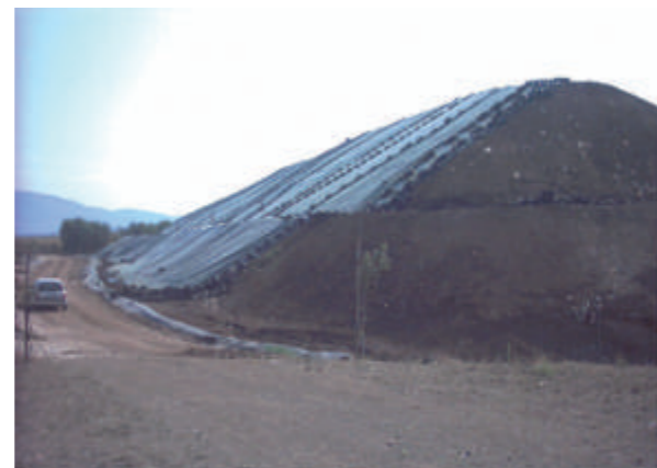
figura 4: Copertura provvisoria zavorrata con pneumatici.
