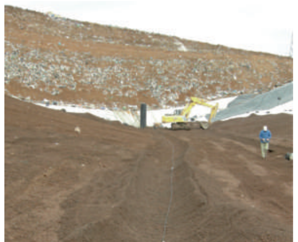
figura 6: Posa degli elettrodi nello strato drenante (sopratelo).
