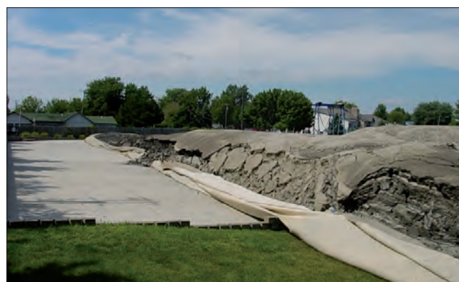
Fig. 4 Case history dewatering area portuale di Island Cove (Tennessee, USA) – S.c.a.r.l.
