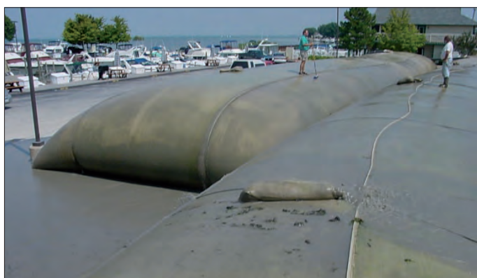
Fig. 3 Case history dewatering area portuale di Island Cove (Tennessee, USA) – S.c.a.r.l.
