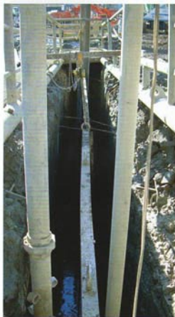
Particolare del giunto a labirinto
