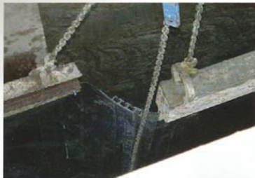
Particolare del giunto a labirinto
